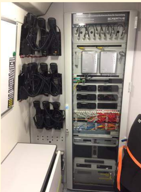
ELW 2.1. Umbau auf Digitalfunk
